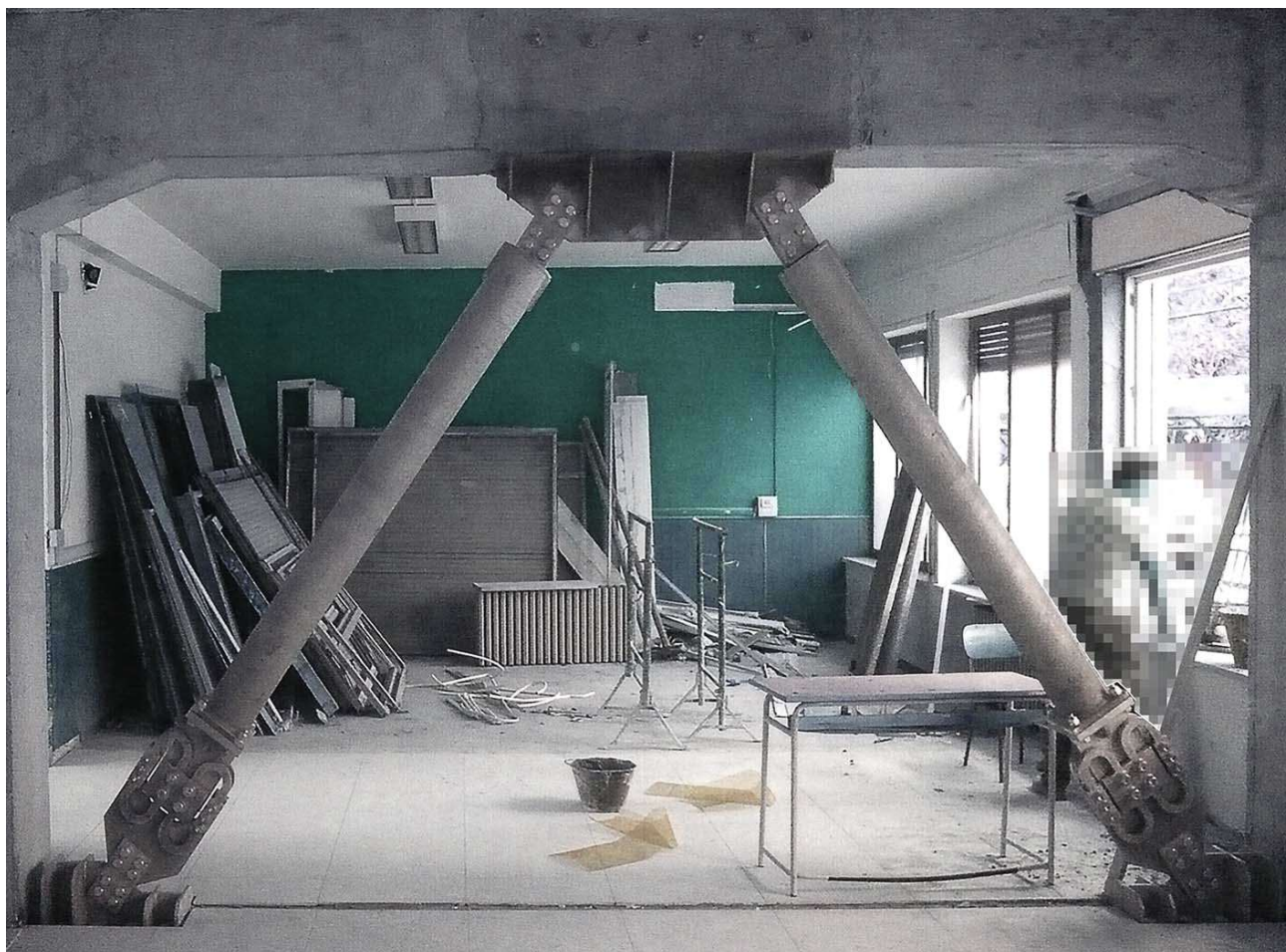
Installazione di controventi dissipativi
